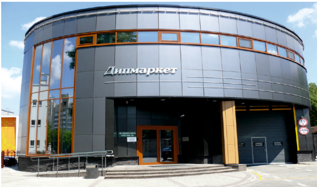
Алюминиевые витражи - стоечно-ригельная система «ALUTECH» ALT F50 Вентилируемый фасад – алюмокомпозитная панель
