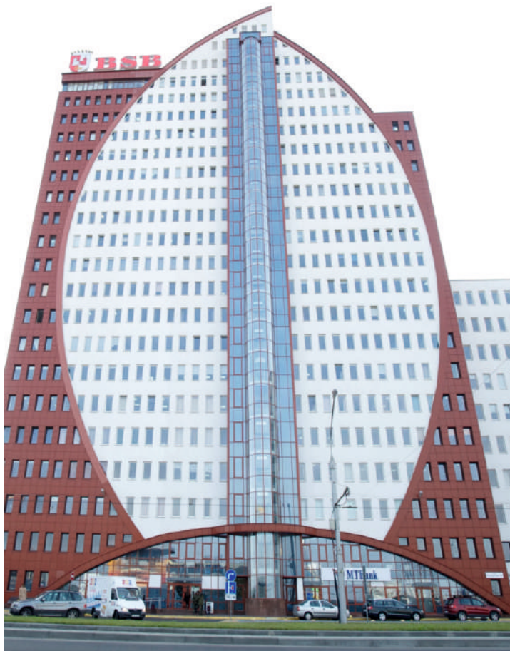
Остекление лифтовой шахты
