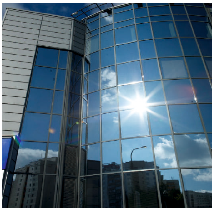
Витражи - стоечно- ригельная система ALUMIL (Польша)
