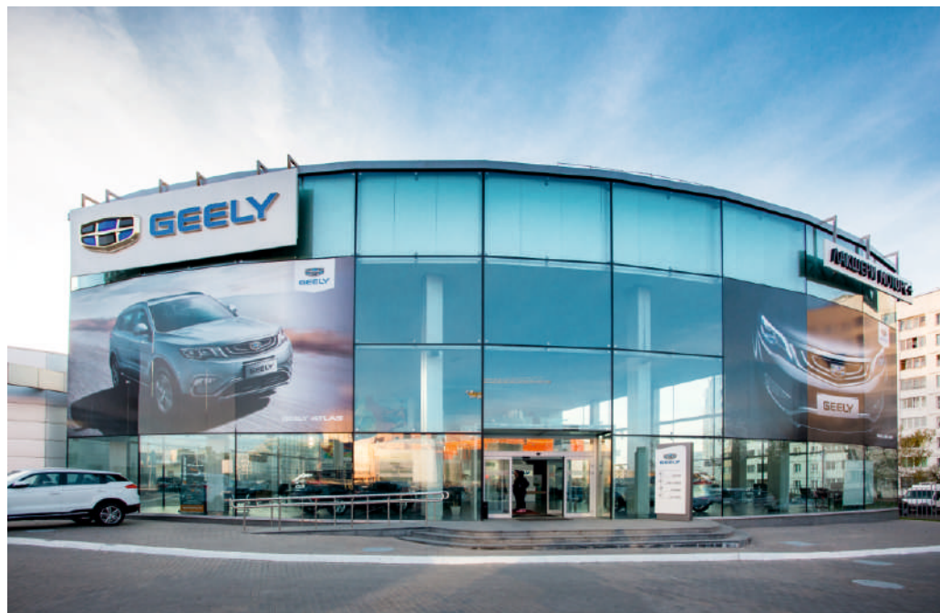
Выставочный павильон автосалона по ул.Орловской г.Минск
