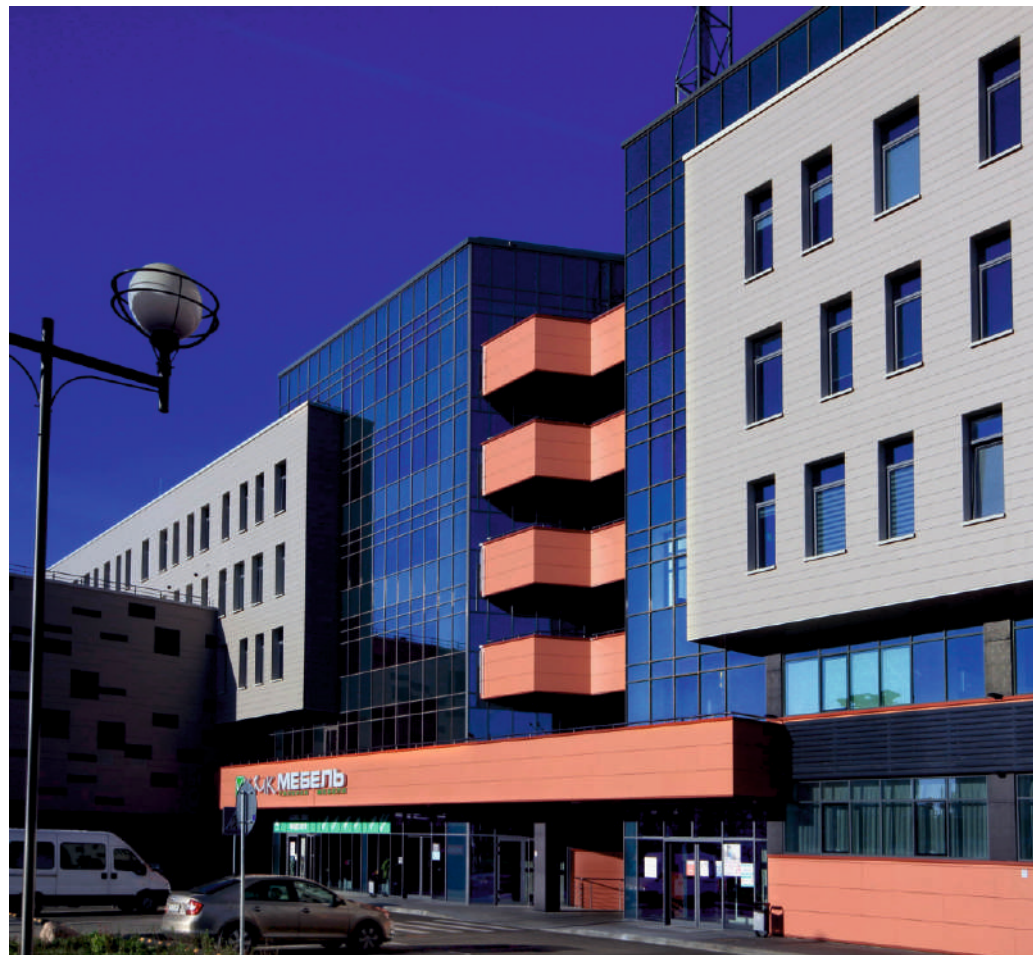
Витражи – стоечно-ригельная система «ALUTECH» ALT F50 Наружное стекло – Guardian SG HP Neutal 50/32
