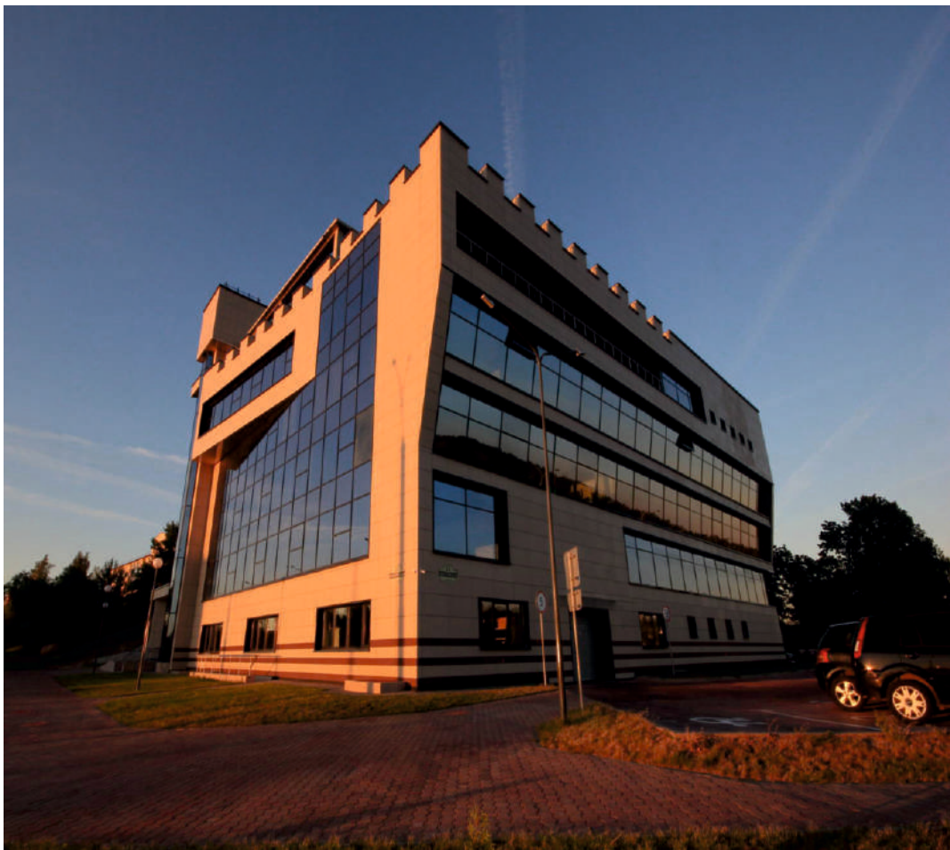
Витражи – стоечно-ригельная система «ALUTECH» ALT F50 Объем работ - 2800м 2 Наружное стекло - Guardian SG HP Royal Blue 38/31
