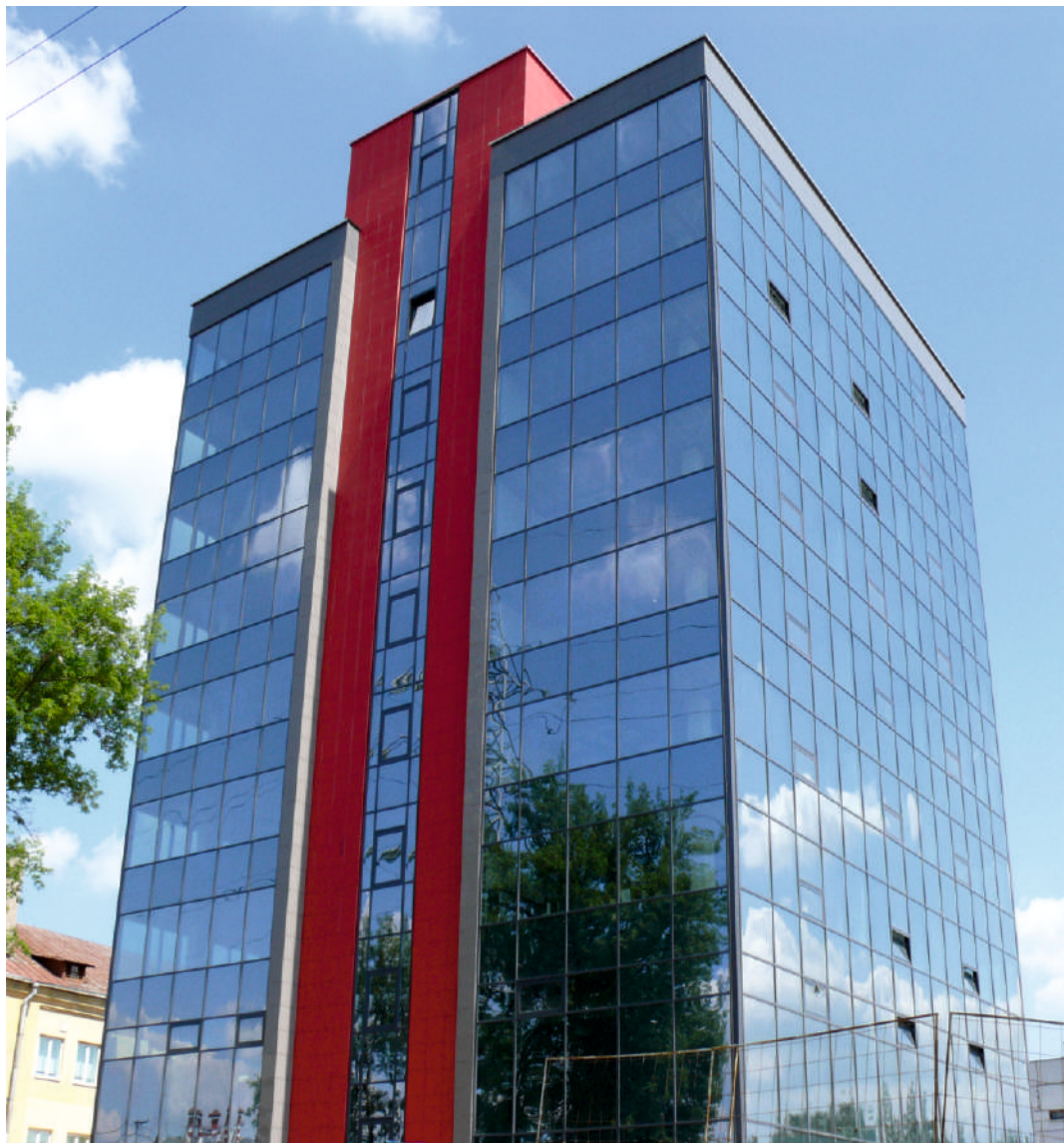
Алюминиевые витражи – ALT F50, вентилируемый фасад - керамогранит
