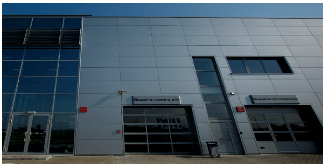
Вентилируемый фасад – алюмокомпозитная панель
