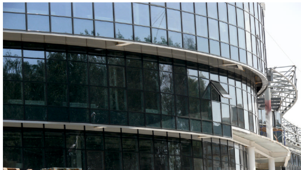
Витражи - стоечно-ригельная система «ALUTECH» ALT F50
