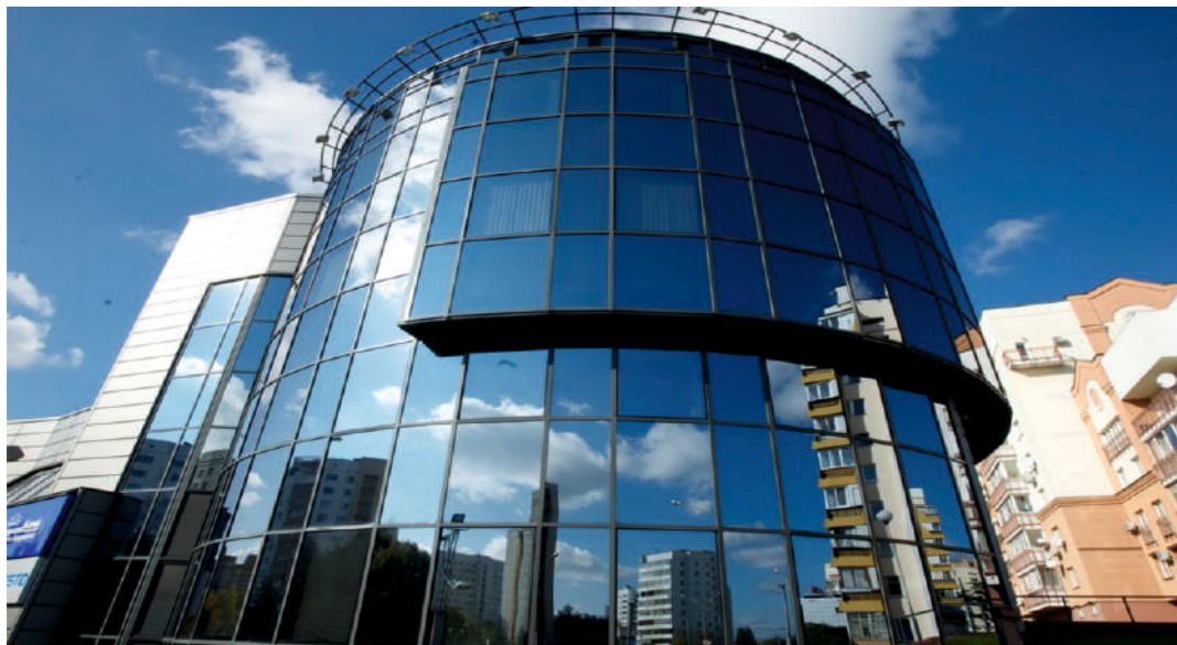
Витражи - стоечно- ригельная система ALUMIL (Польша)
