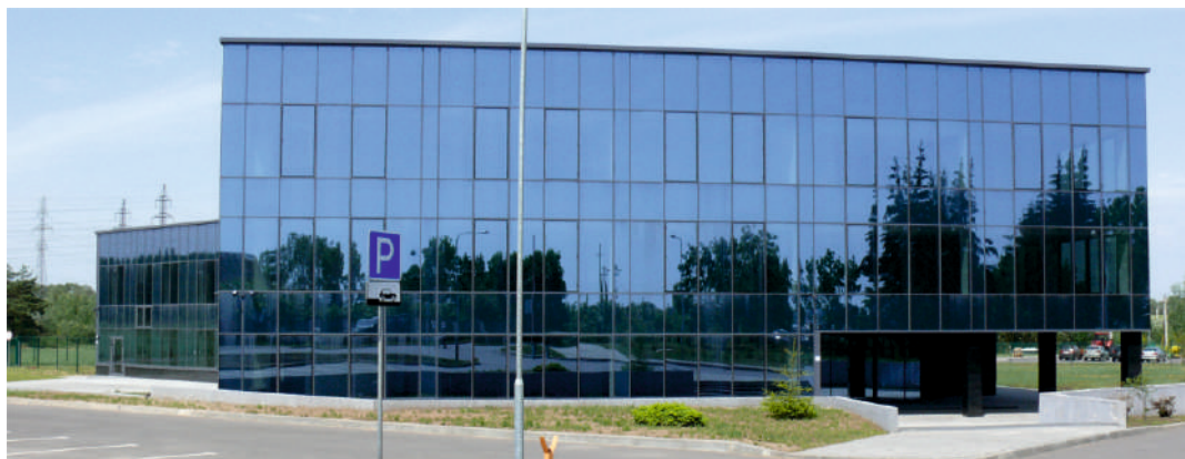
Алюминиевые витражи - стоечно-ригельная система «ALUTECH» ALT F50 - SG
