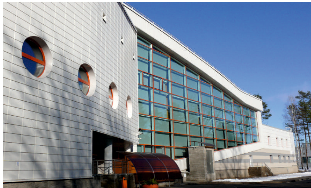
Алюминиевые витражи - стоечно-ригельная система «ALUTECH» ALT F50
