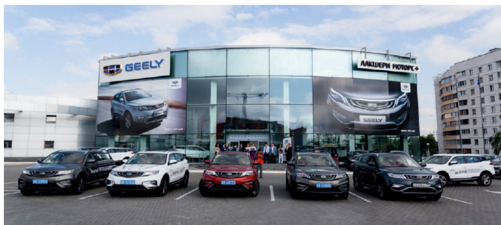
Спайдерное остекление, двери из алюминиевого профиля ALT, вентилируемый фасад – алюмокомпозитная панель
