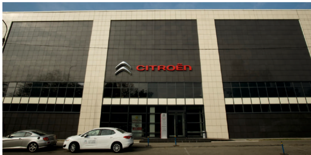
Алюминиевые витражи – ALT F50, вентилируемый фасад - керамогранит
