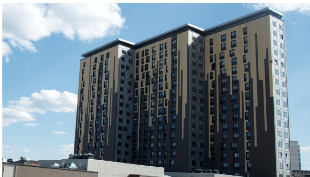
Торговый центр «Красный кит» РФ, г.Мытищи
