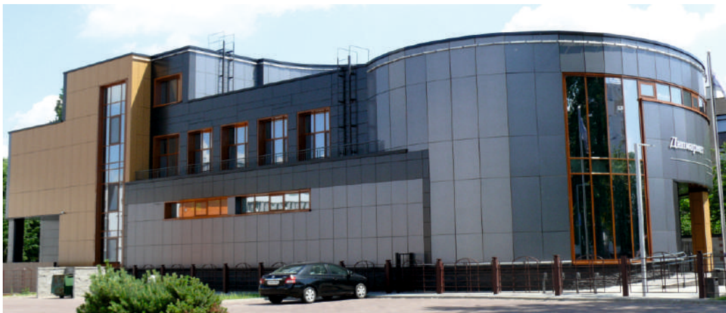
Торгово-хозяйственное здание Дипмаркет г.Минск, ул.Коммунистическая
