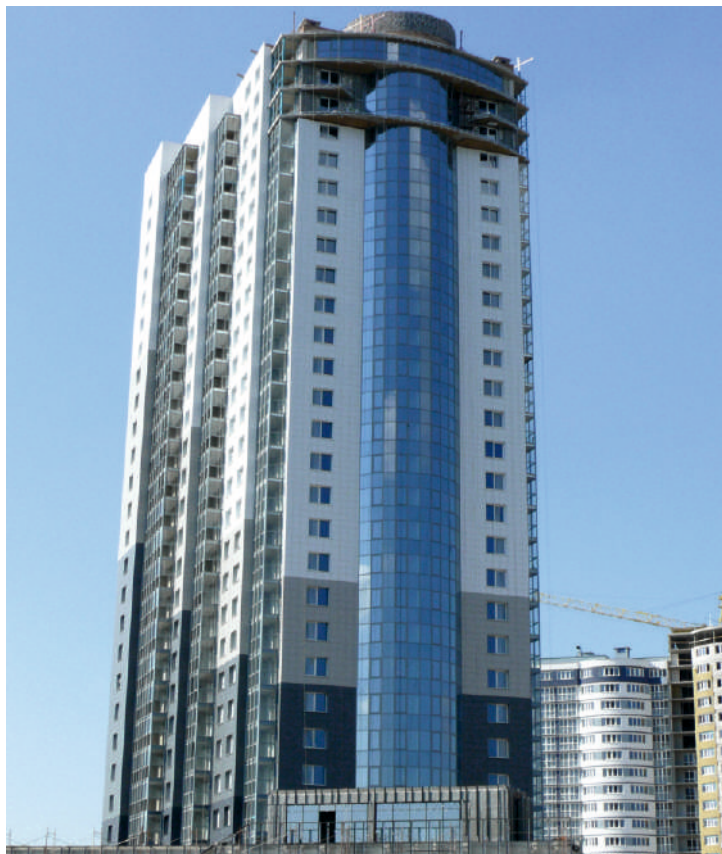
Жилой дом «3D» с торгово-административными помещениями в микрорайоне «Лебяжий» г. Минск
