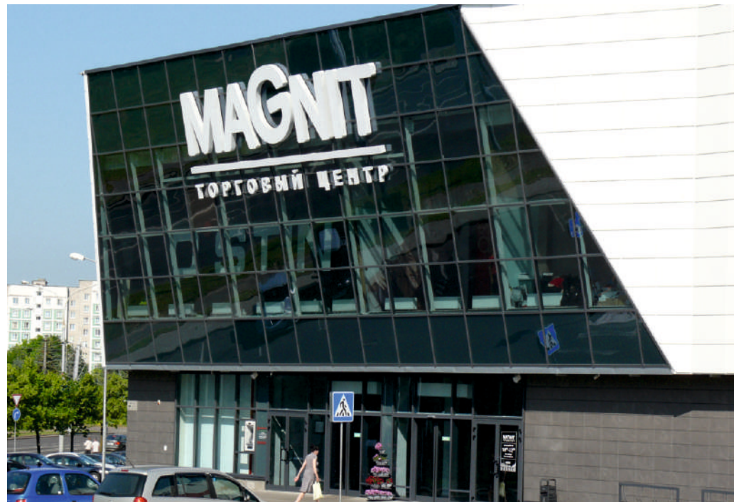
Торговый центр «МАГНИТ» г.Минск, пр.Дзержинского
