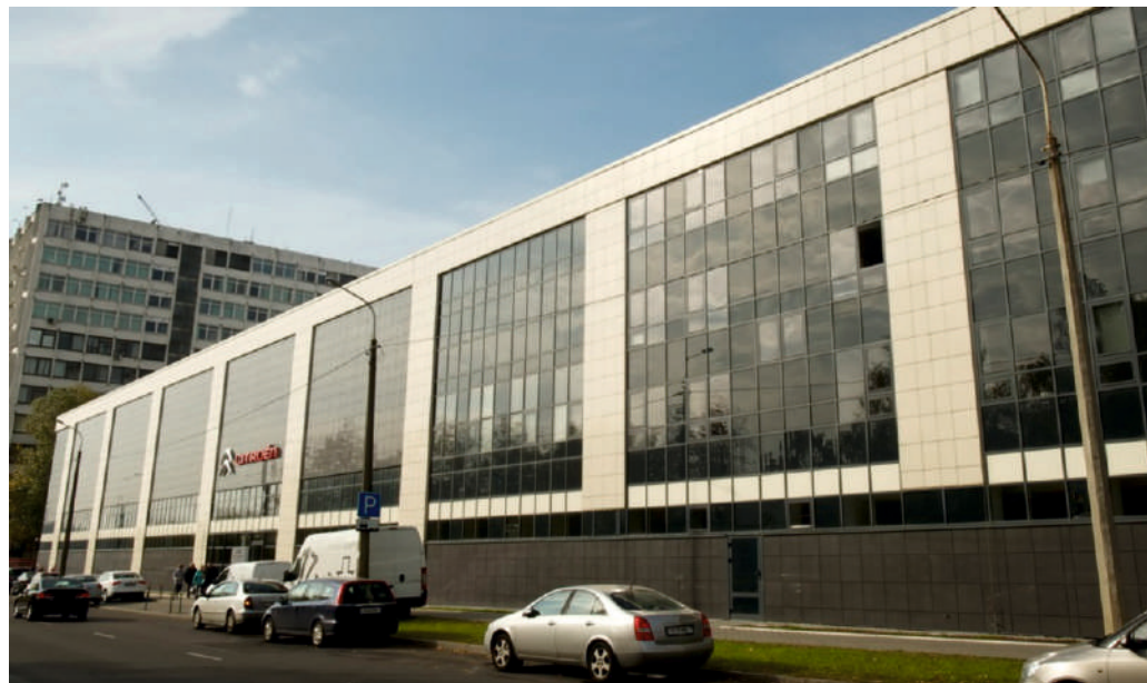
Административно-производственное здание ЗАО «Белтехэкспорт»
